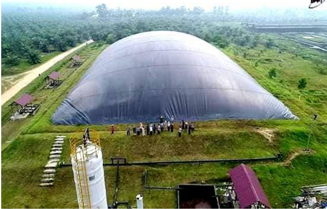
國外場域示意圖-印尼廖內省的棕櫚油廠裝設 700 千瓦的沼氣發電廠
