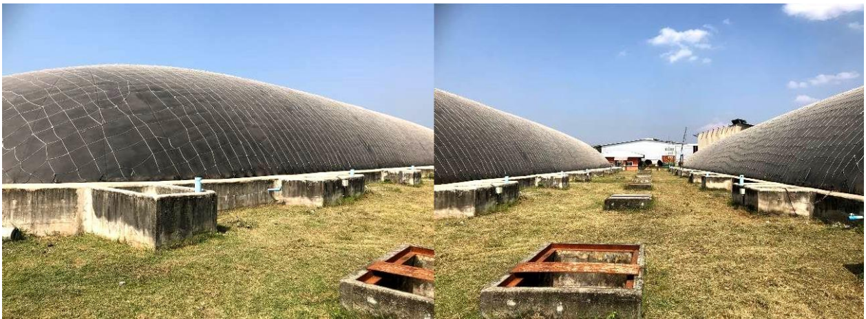
國外場域示意圖-泰國北大年府的棕櫚油廠裝設 2000 千瓦的沼氣發電廠。
